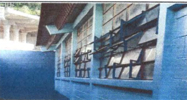
Foto 5: Sustitución de vidrios (modulo de aulas)
