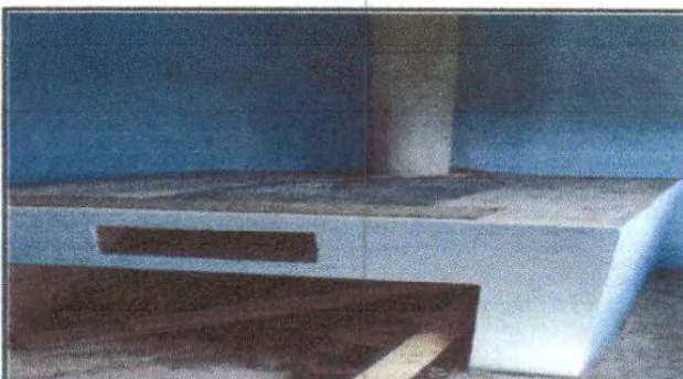
Foto 12: Sustrucción de estufa rural completa, incluye chimenea y plancha de metal (cocina)
