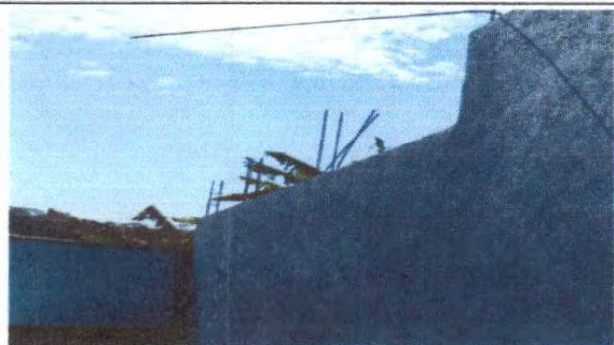
Foto 1: Reparación de muro de contención
