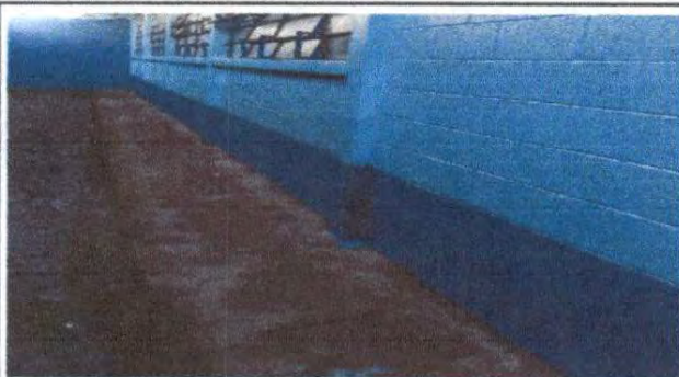
Foto 15: Pintura en muros exteriores (modulos de aulas)
