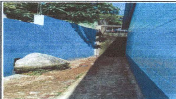
Foto 2: Reparación de muro perimetral de block
