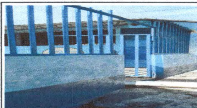
Foto 11: Pintura en muros exteriores (modulos de aulas, porton y muro perimetral)
