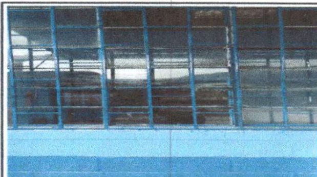
Foto 10: Sustrucción de balcones de metal y mantenimiento de estructura de metal de ventanas de vidrio (modulos de aulas)
