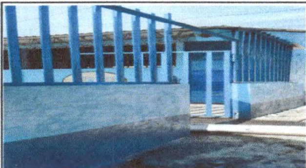
Foto 9: Mantenimiento de (porton) (lijado, cambio de tubo, sujeciones y aplicación de pintura)
